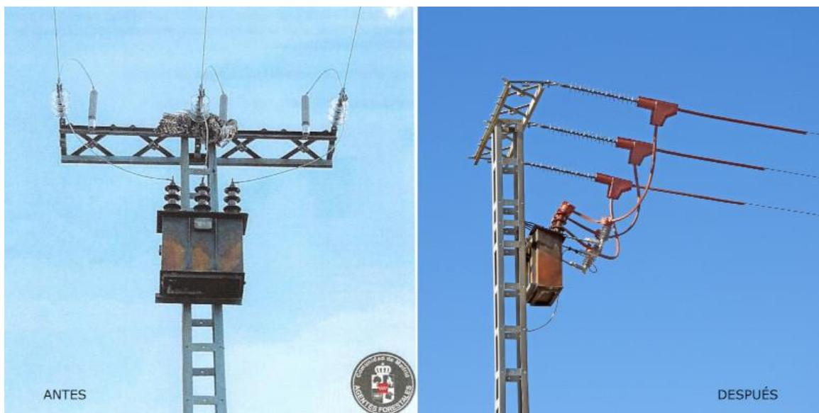
*Ilustración 5. Apoyo con transformador donde se había electrocutado un búho real transformado.*
