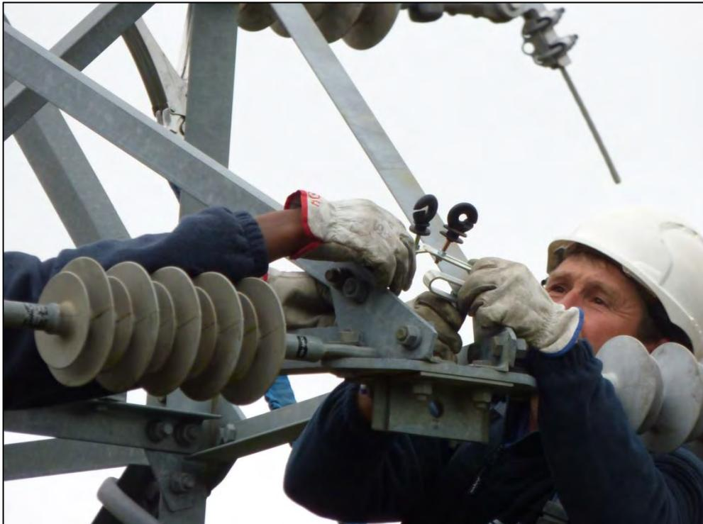
La unidad generadora compuesta por batería y placa solar se ha instalado orientada hacia el sur en una pequeña ménsula que ha sido atornillada a la celosía de la torreta, de forma que no es accesible al público y se encuentra convenientemente señalizada. El circuito se cierra (realizando el "disparo") por contacto de las aves entre el cable (fase) y el armado (tierra).
