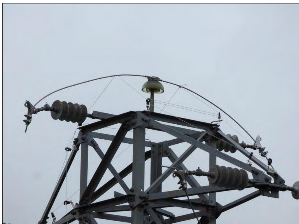
En la torreta de alineación en bóveda se han instalado dos circuitos interconectados. Uno recorre la cogolla del armado, de una punta a otra de la celosía, prestando especial atención en cubrir los extremos de la cruceta y las cartelas exteriores, así como las traviesas que sobresalen en la cima y suelen ser habitualmente utilizadas por las rapaces como posaderos (*Fig. 10*).
