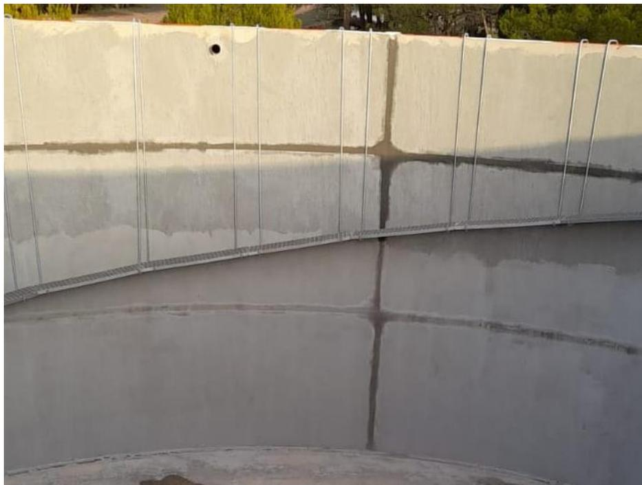
**Imagen 3.** Rampa de trámex plástico en depósito circular.
