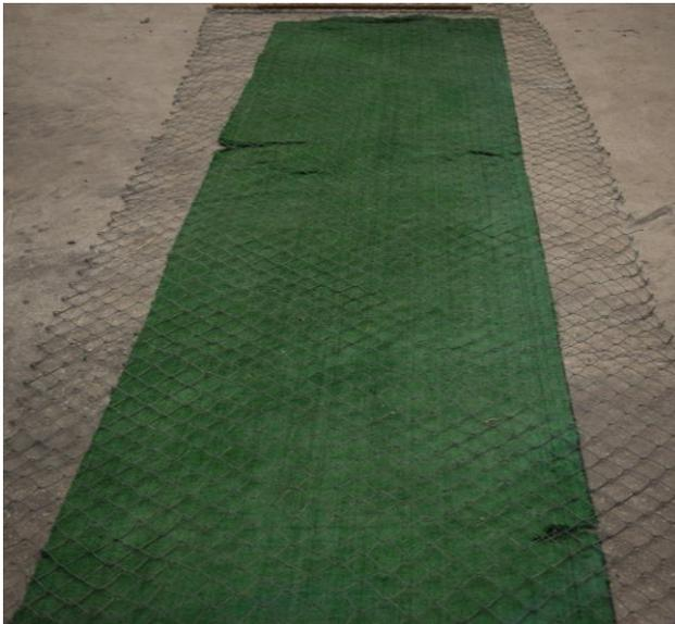
**Imagen 15.** Rampa de tela metálica de simple torsión sobre césped artificial.
