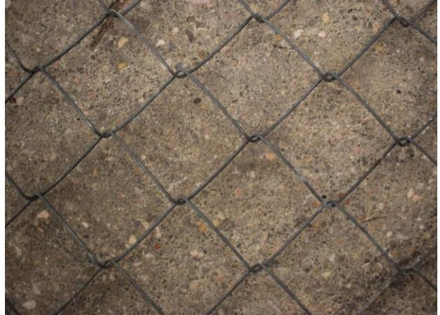
**Imagen 2.** Detalle tela metàlica de simple torsión.
