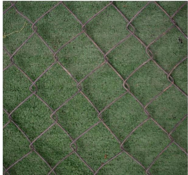
**Imagen 16.** Detalle rampa de tela metálica de simple torsión sobre césped artificial.
