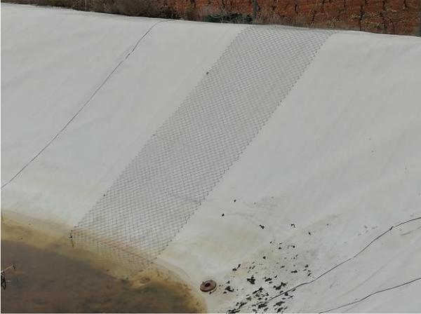
**Imagen 1.** Rampa de tela metàlica de simple torsión.
